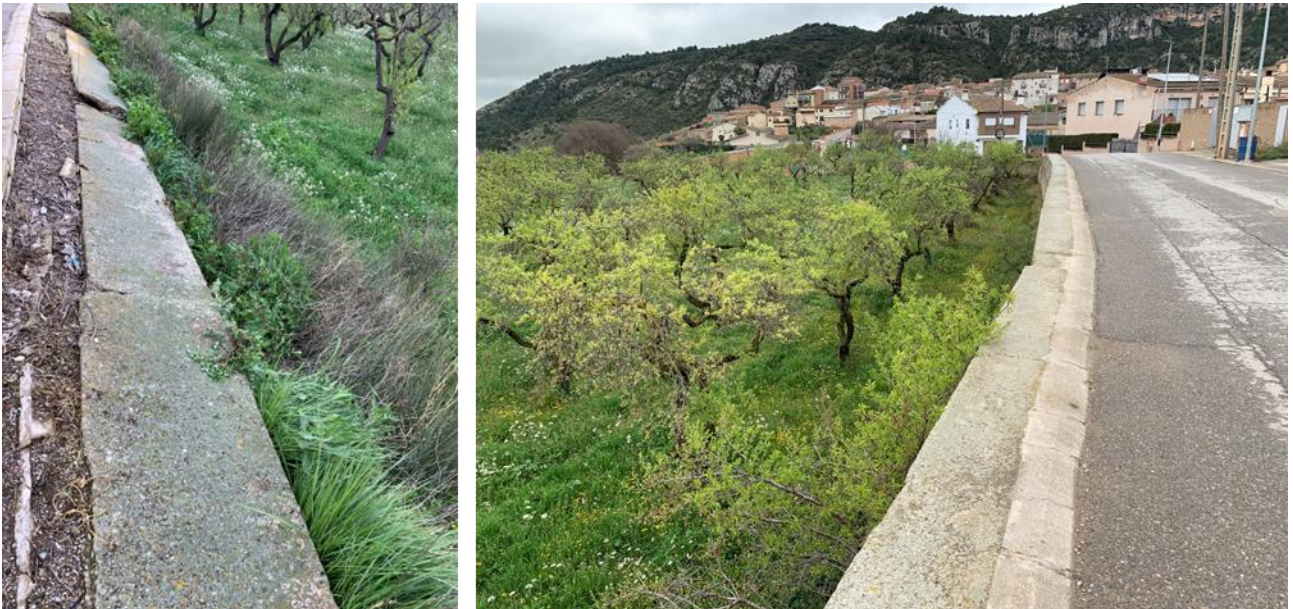
Imatge 4. Desnivell existent entre el vial i la parcel·la adjacent, i tram enfonsat.
